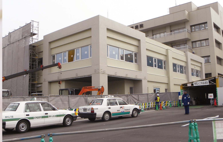
▲写真1 建設中の高度救命救急センター
