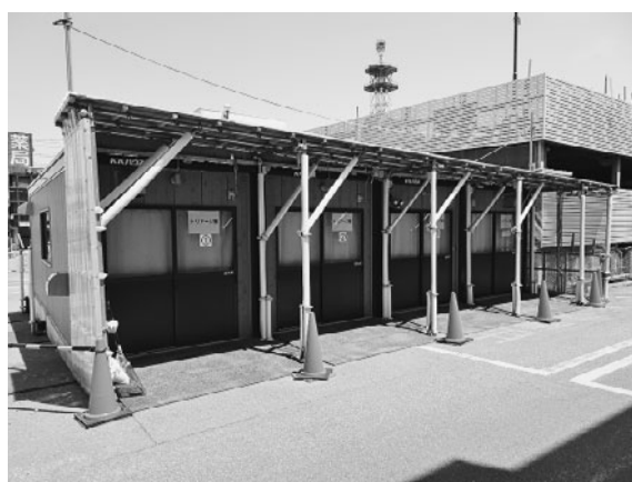
トリアージ棟（仮設）
