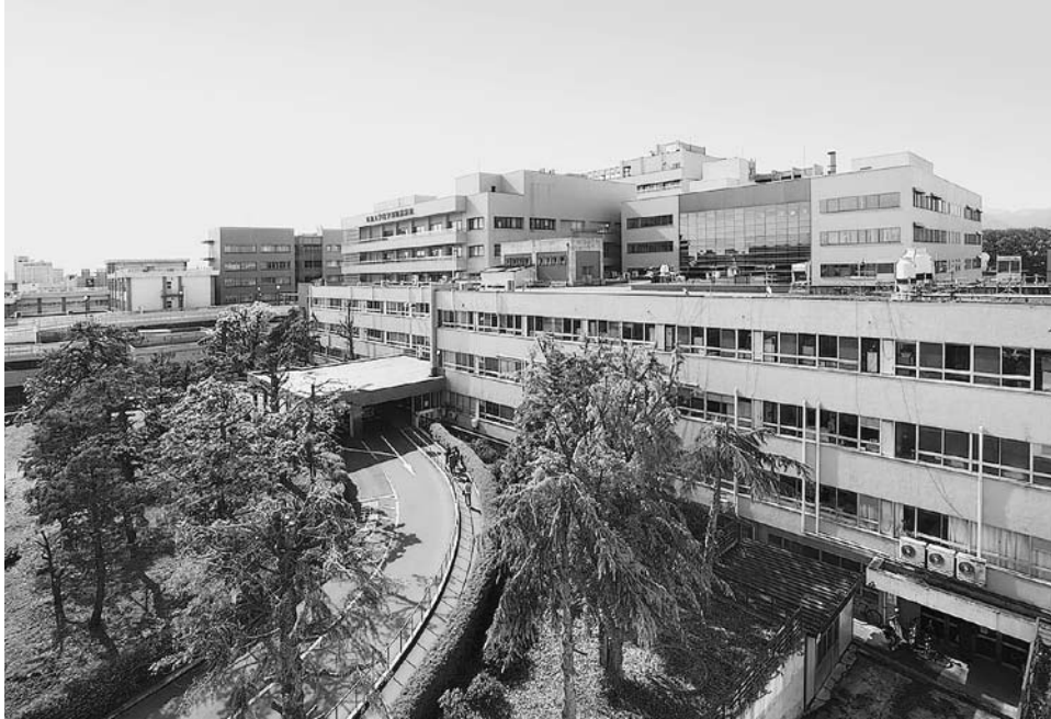
旧外来診療棟屋上より
